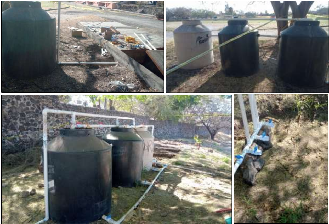
Figura 4.- Colocación de las bombas y los tres biodigestores, así mismo se aprecia el proceso de construcción de las tinas de sedimentación y absorción.
