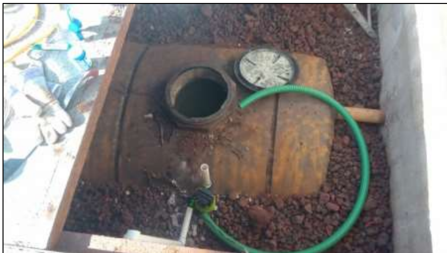
Figura 2.- En esta imagen se aprecia el biodigestor en funcionamiento, mismo que tiene una capacidad aproximada de 4000 litros.
