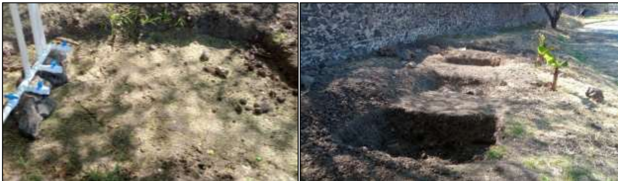
Figura 7.- Tinan ciegas de absorción de aguas tratadas, así mismo se puede apreciar que se están sembrando plantas ornamentales y algunas otras especias nativas de la zona.
