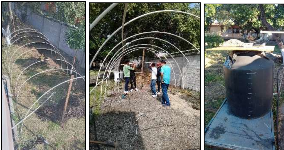
Figura No. 2. Diseño y construcción del invernadero, utilizando tubos de PVC y pedacería de varillas.
